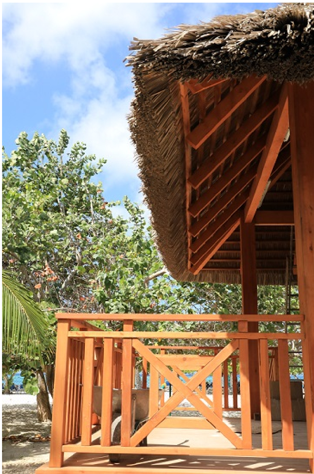
Servicio: Construcción de ranchones.
