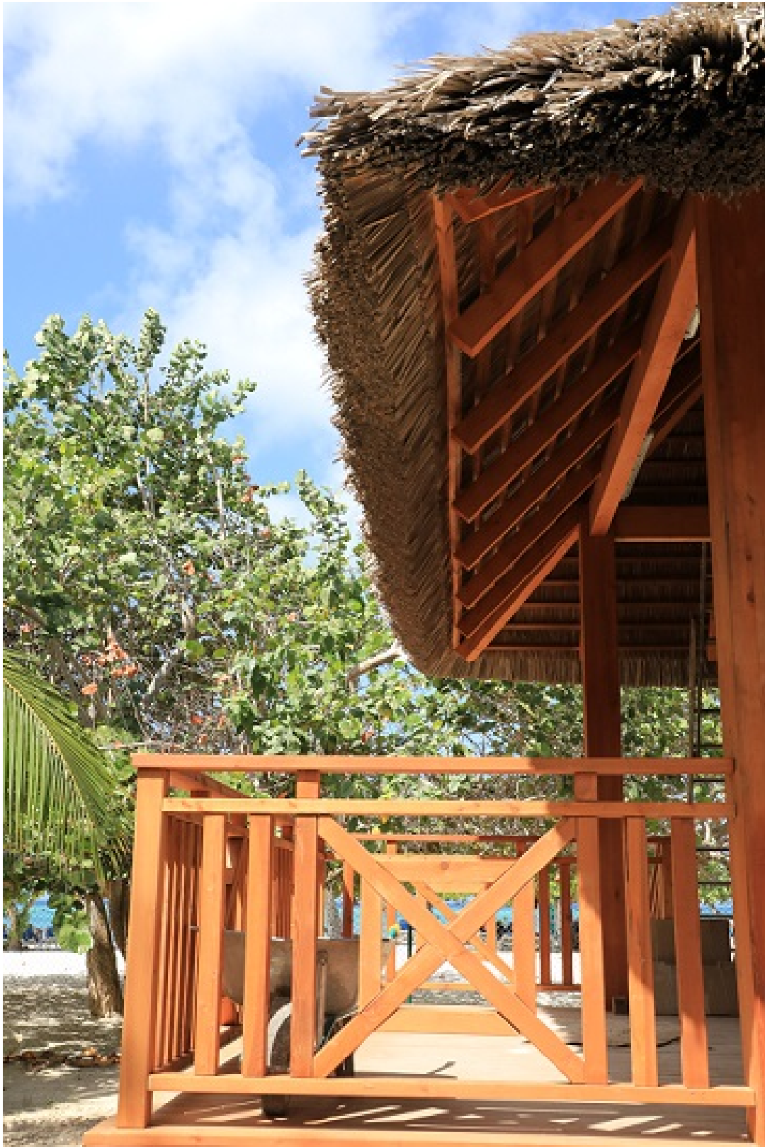
Servicio: Construcción de ranchones.
